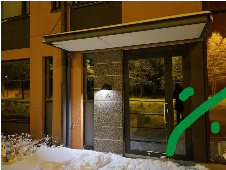
Bild 4. Belysningen av högre kvalitetet på grannhögghuset på Ullasbackavägen skapar inget direkt riktat ljus mot grannhusens fönster utan är riktat nedåt på korrekt sätt.
