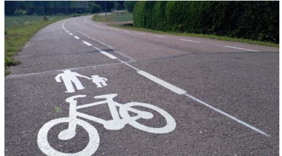
Pyhtäänkuja, Pyhtää 250 m Kadun reunoihin on maalattu kävelijöitä ja pyöräilijöitä varten 1,5 m levyiset kaistat. Autoilijat käyttävät keskelle jäävää kaksisuuntaista kaistaa, jonka leveys on 3m. Ympäristö on avara.
