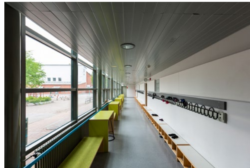
Käsijohteiden käyttö on estetty kalusteilla.
