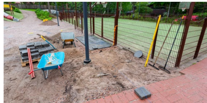
Tilakeskuksen laatoitustyö kesällä 2020 parantaa valmistuessaan liikkumista.
