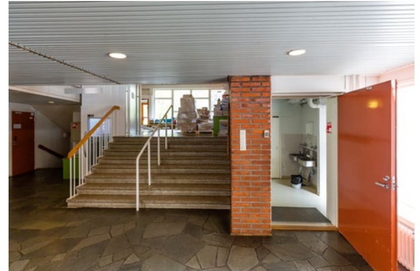
Yläkuva: lattiassa merkittävä korkeusero siirryttäessä opetustilaan. Käsijohtimet ovat kaikki yhdessä korkeudessa.
