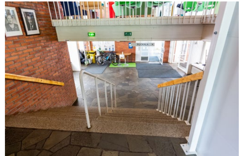
Yläkuva: lattiassa merkittävä korkeusero siirryttäessä opetustilaan. Käsijohtimet ovat kaikki yhdessä korkeudessa.
